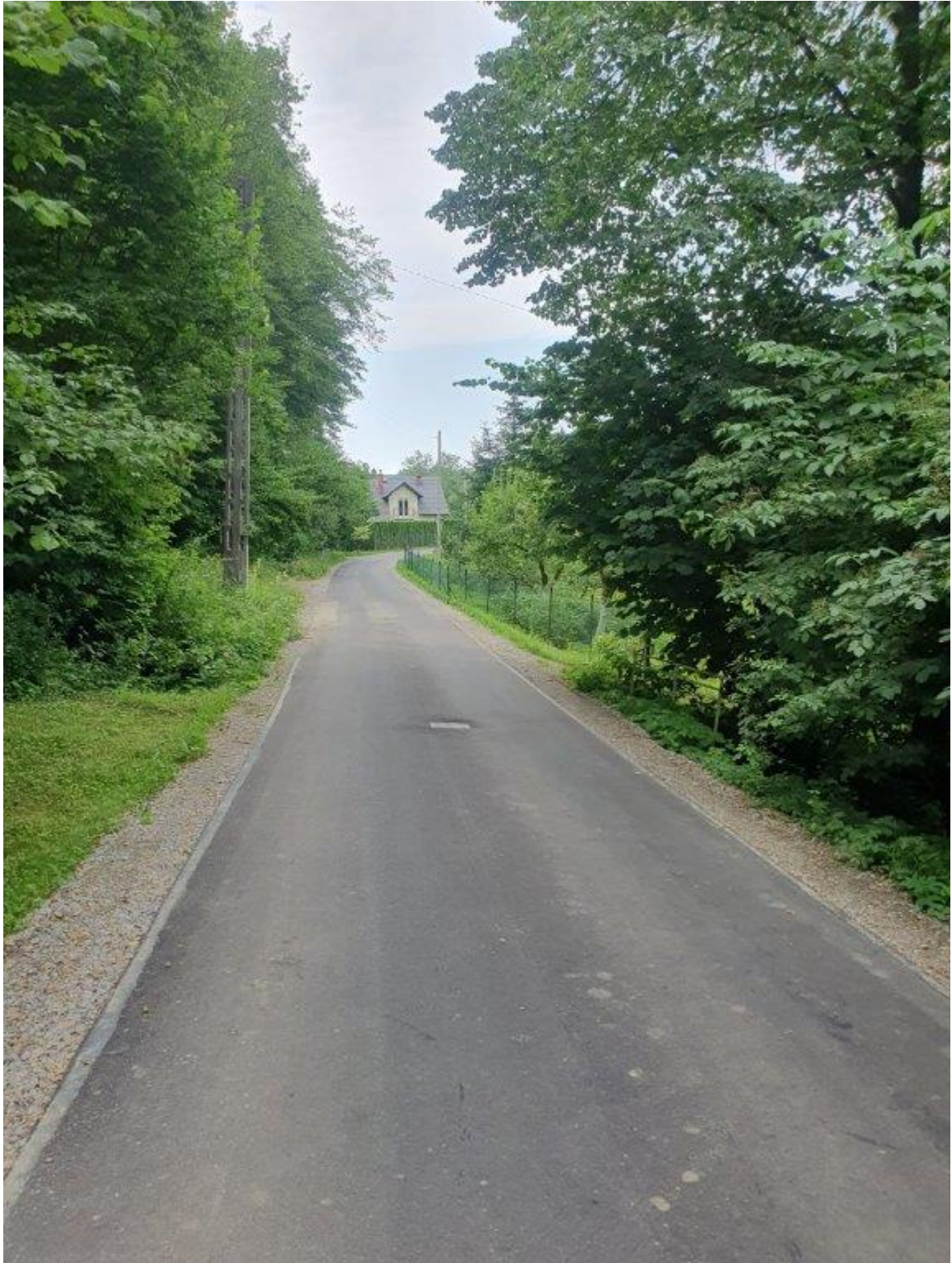
Droga przez wieś w Cergowej
