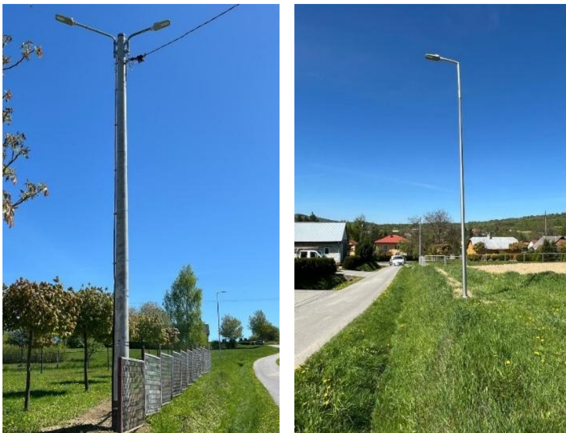
Oświetlenie uliczne w Głojscach.
