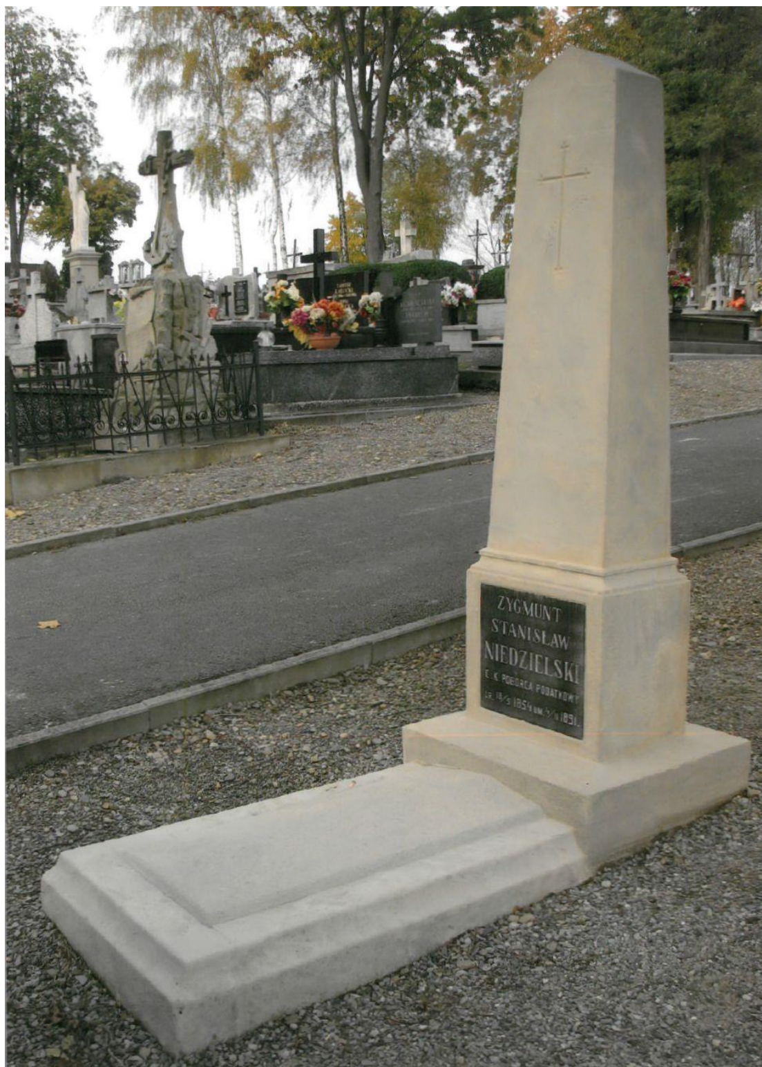
Fot.9 Nagrobek Zygmunta Niedzielskiego, ok. 1892 r., cmentarz w Dukli. Całość po konserwacji. Powierzchnia kamienia została oczyszczona i uzupełniona. Zrekonstruowano płytę wierzchnią wewnątrz murku w masie piaskowo-cementowo- wapiennej. Lokalnie scalono kolorystycznie kity z kamieniem. Tablicę inskrypcyjną oczyszczono, uzupełniono ubytki i przeszlifowano. Październik 2016 r.
