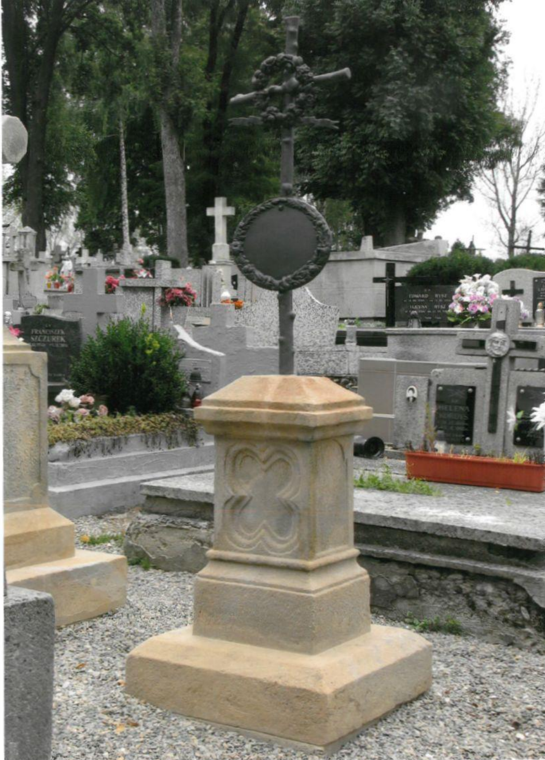
Fot.5 Nagrobek nieznanej osoby, III ćw. XIX w., cmentarz w Dukli. Całość po konserwacji. Powierzchnia kamienia została oczyszczona i uzupełniona. Żeliwny krzyż wypiaszkowano, pomalowano i powtórnie osadzono na zwieńczeniu. Wrzesień 2015 r.
