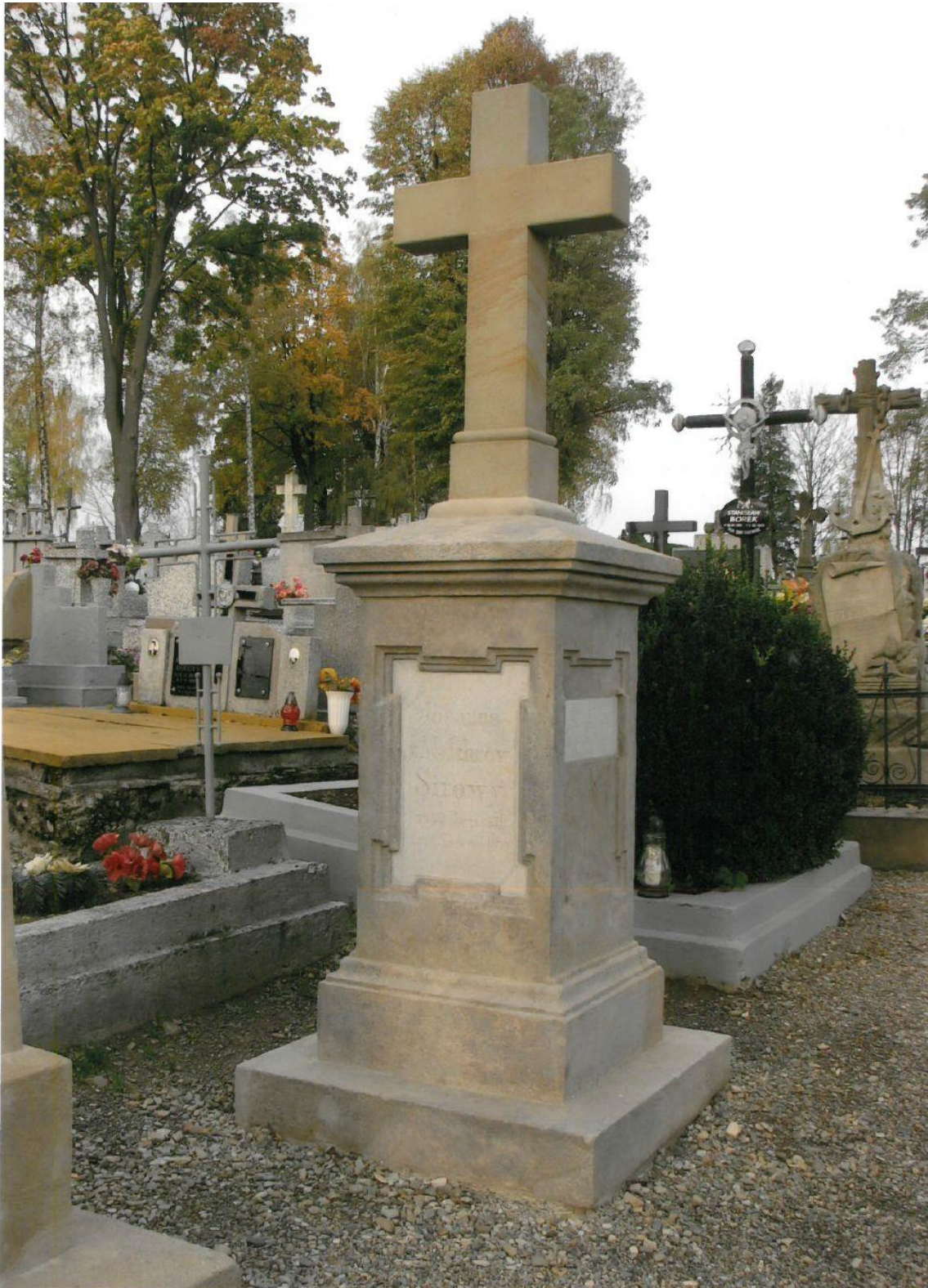
Fot.8 Nagrobek Johann Sirowy, ok. 1879 r., cmentarz w Dukli. Całość po konserwacji. Powierzchnia kamienia została oczyszczona i uzupełniona. Lokalnie scalono kolorystycznie kity z kamieniem. Zrekonstruowano w piaskowcu element zwieńczenia w formie krzyża. Tablice inskrypcyjne zostały oczyszczone, uzupełniono ubytki i przeszlifowano. Październik 2016 r.
