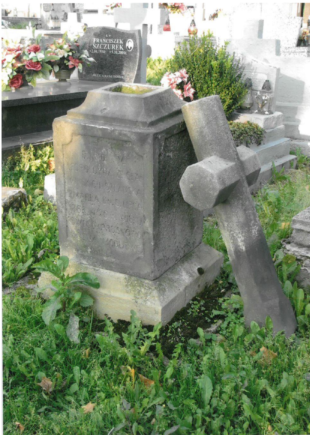
Fot.1 Nagrobek Leopoldyny Szlanskiej, III ćw. XIX w., cmentarz w Dukli. Całość przed konserwacją. Nagrobek lekko przekrzywiony na lewy bok, krzyż zdemontowany. Powierzchnia kamienia mocno zabrudzona, a stopień pokryty grubymi nawarstwieniami mchu. Październik 2014 r.
