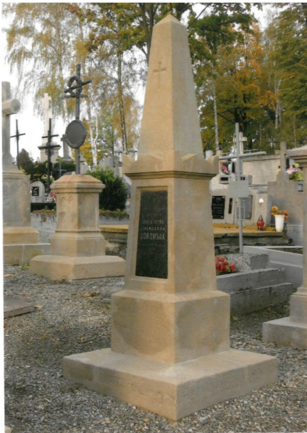
Fot.7 Nagrobek Marii Borowskiej, ok. 1873 r., cmentarz w Dukli. Całość po konserwacji. Powierzchnia kamienia została oczyszczona i uzupełniona. Lokalnie scalono kolorystycznie kity z kamieniem. Zrekonstruowano w piaskowcu element zwieńczenia w formie obelisku, z wyciętym krzyżem na przedniej ścianie. Tablica inskrypcyjna została oczyszczona, uzupełniono ubytki i przeszlifowano. Październik 2016 r.
