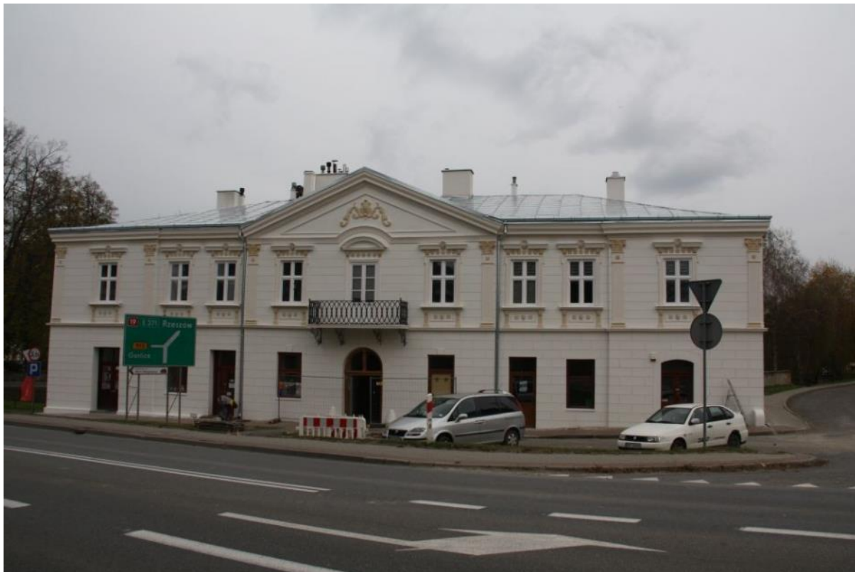
Widok elewacji frontowej wyremontowanej kamienicy przy ul. 3-go Maja
