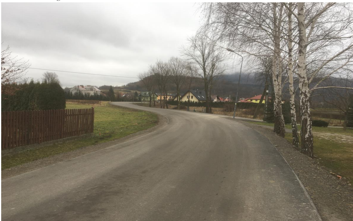
Przebudowa drogi w Cergowej
