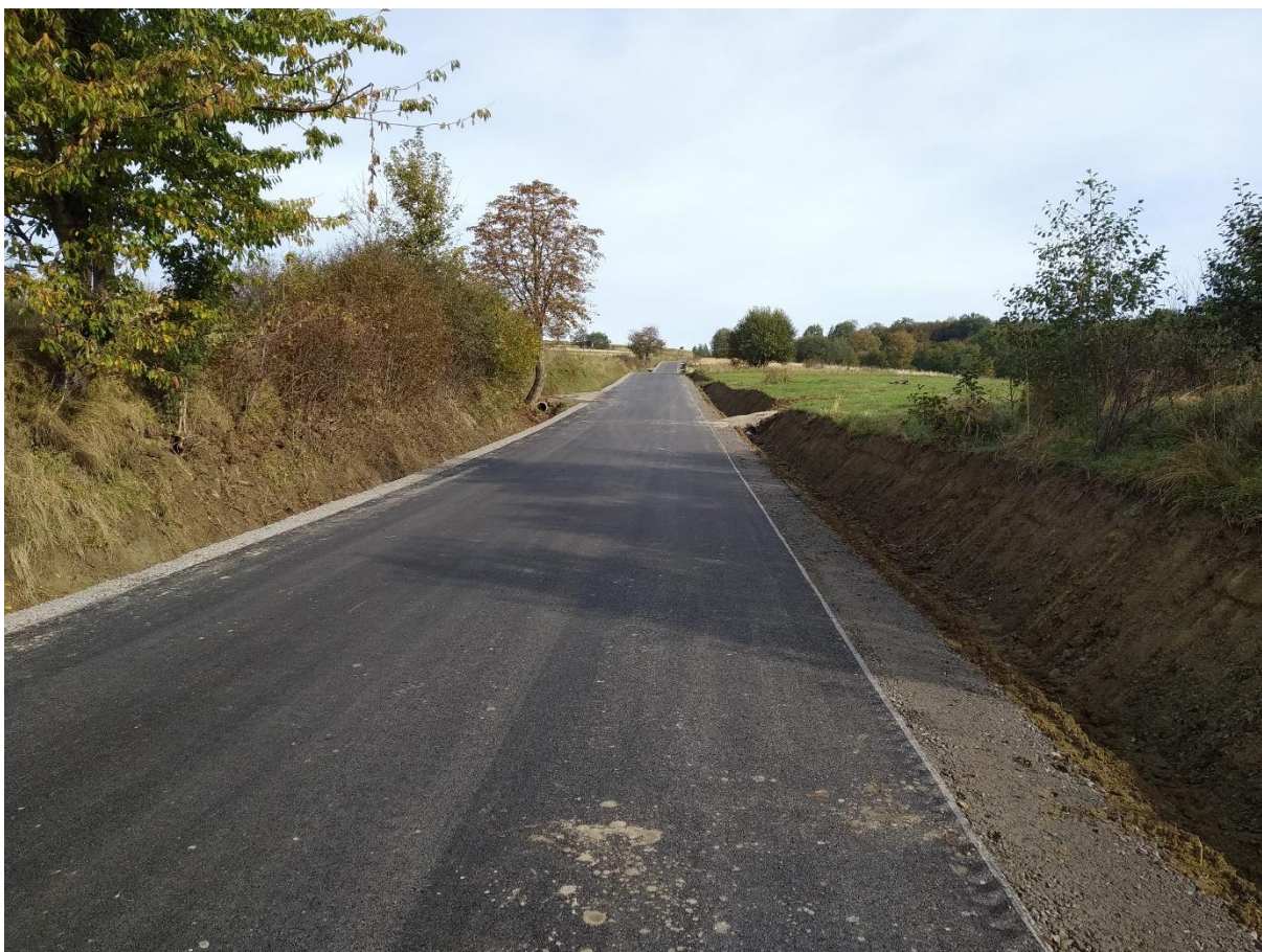
Przebudowa drogi w Łękach Dukielskich
