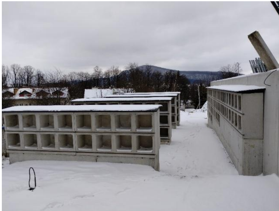
Fot. Kaplica cmentarna w trakcie budowy
