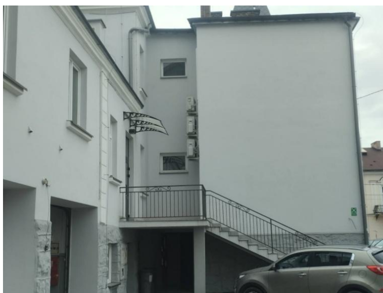
Fot: Budynek Ośrodka Kultury w Dukli, wyposażony w instalację odgromową oraz klimatyzatory.
