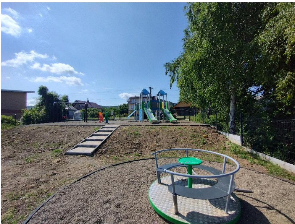
Fot: Plac zabaw w Teodorówce – montaż wielofunkcyjnego urządzenia zabawowego ze zjeżdżalnicami.
