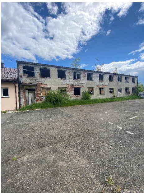
Fot: Stan budynku przyległego do ŚDS w Cergowej – przed rozbiórką (zdj. 1), w trakcie rozbiórki (zdj. 2) oraz pozyskany materiał z rozbiórki, którym utwardzono drogi gminne (zdj. 3)
