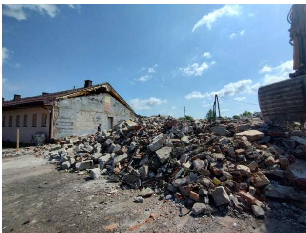
Fot: Stan budynku przyległego do ŚDS w Cergowej – przed rozbiórką (zdj. 1), w trakcie rozbiórki (zdj. 2) oraz pozyskany materiał z rozbiórki, którym utwardzono drogi gminne (zdj. 3)
